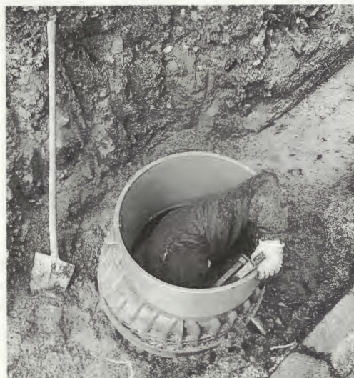
Kontrolle der Schächte vor dem Verfüllen.
