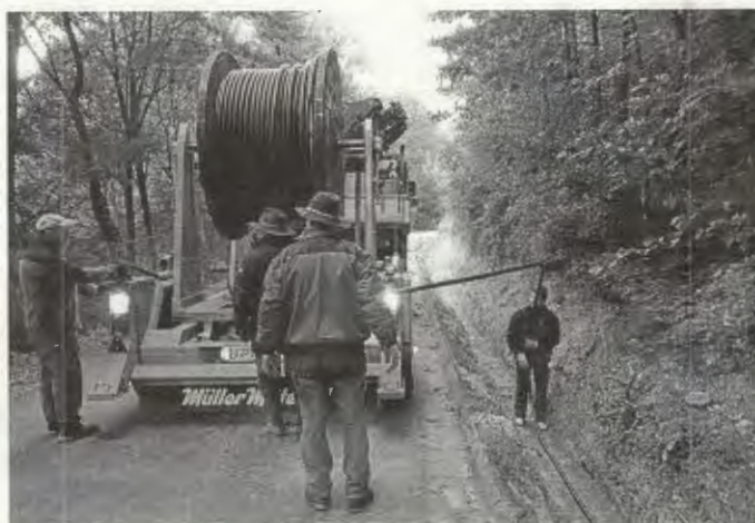
Verlegen des Stromkabels in Zusammenarbeit mit dem Albwerk
