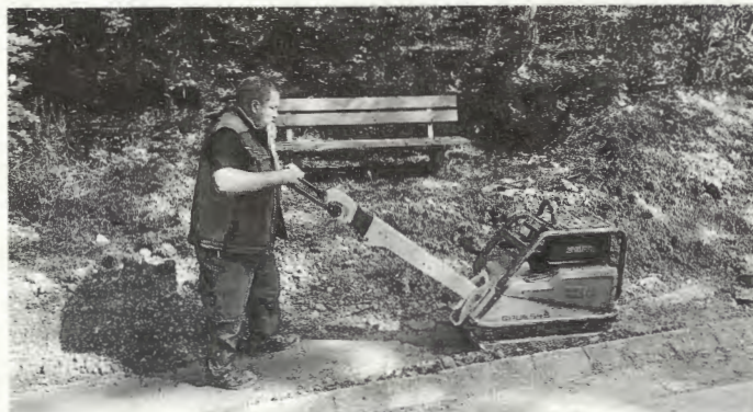
Verdichten des aufgefüllten Grabens
